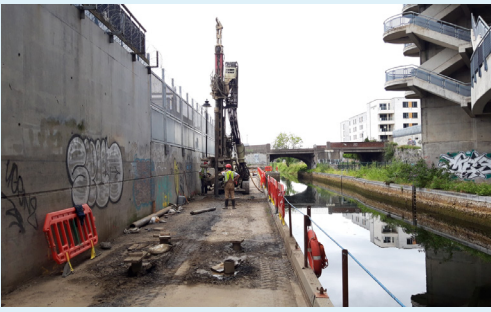
Bunsraith a shuiteáil i leith struchtúr an rampa gar do Pháirc an Chrócaigh
