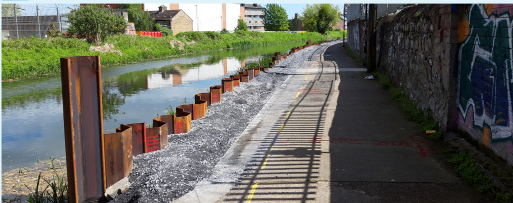
Bruach na canála a neartú idir Páirc an Chrócaigh agus Droichead Uí Chléirigh
